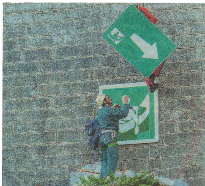
La pose du premier panneau pour indiquer la passe à canoës.
